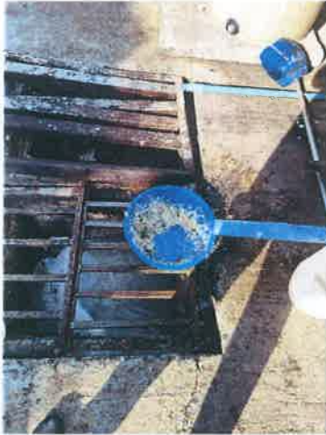
รูปที่ 2-13 แสดงไขมันที่ได้จากการตัดออก จากถังดักไขมัน
