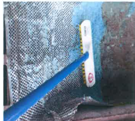
รูปที่ 2-16 ติดตั้งตะแกรงดักขยะที่บ่อพัก (สุดท้าย)
